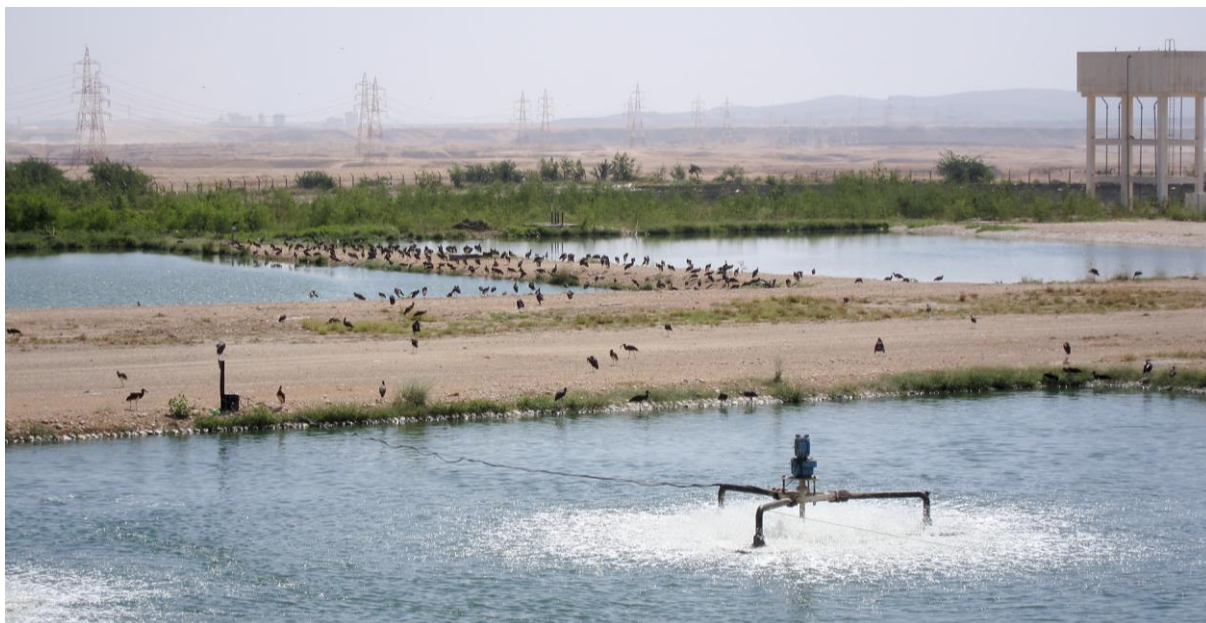
Raysut sewage treatment plant var helt nerlusat av abdimstorkar på grusvallarna mellan dammarna. Från soptippen (långt i bakgrunden) kom rovfåglar inglidande.
