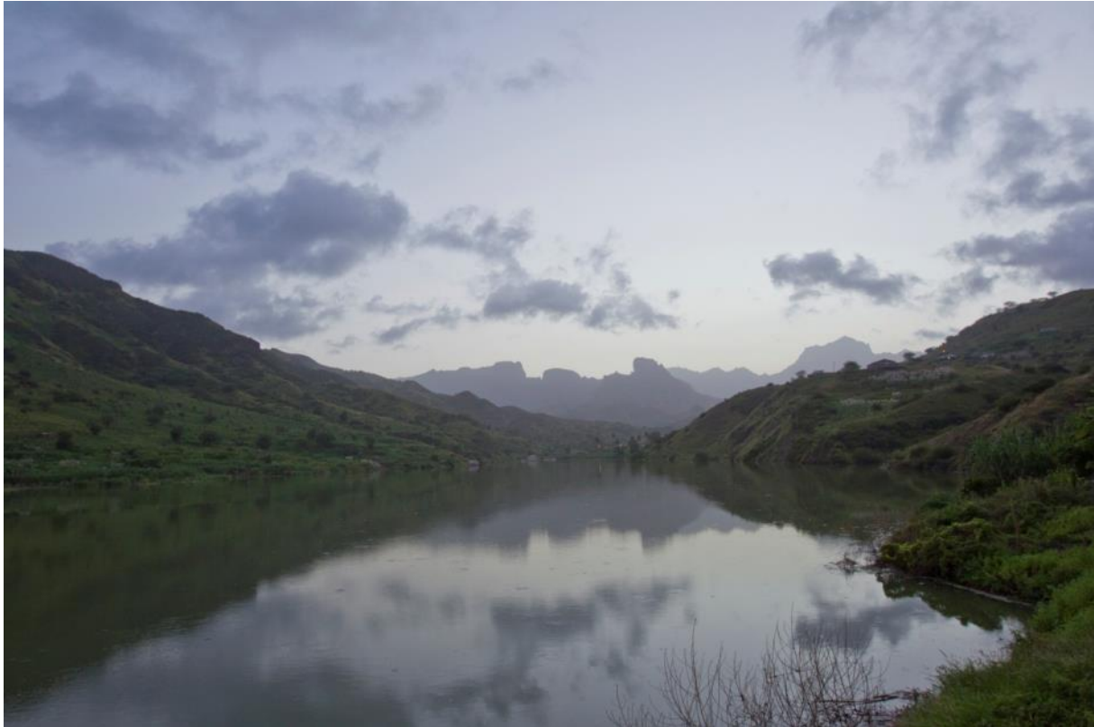
Barragem de Poilão, Santiago
