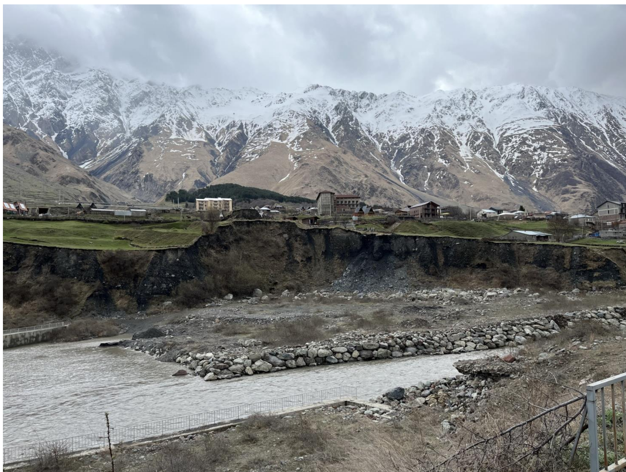
The Dam, Stepantsminda. Häcklokal för murkrypare.
